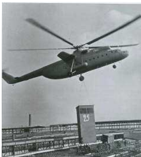
Un Mi-6 installe un système de ventilation sur un site industriel en 1969.
